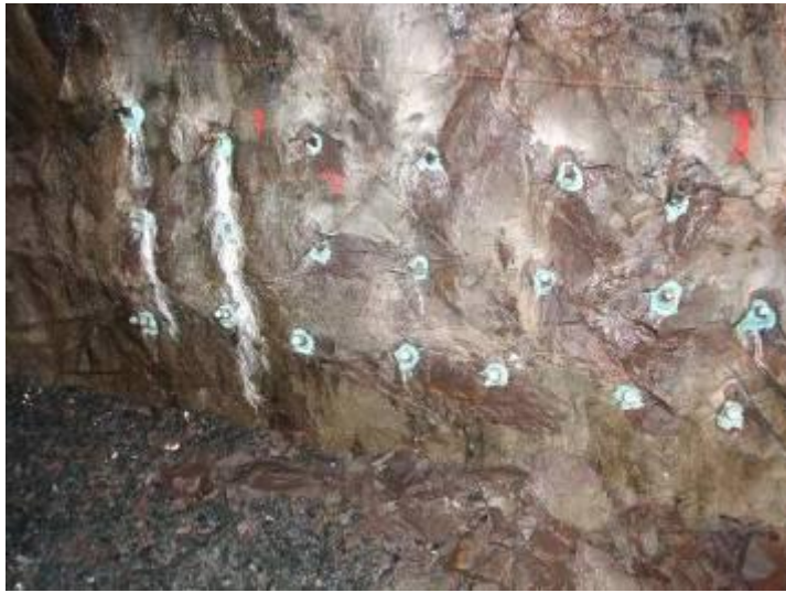
Figur 6. Bergbultar monterade i Äspötunneln
