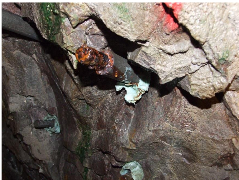
Figur 8. Delvis utdragen och ingjuten kolstålsbult efter åtta års exponering i Muskötunneln.
