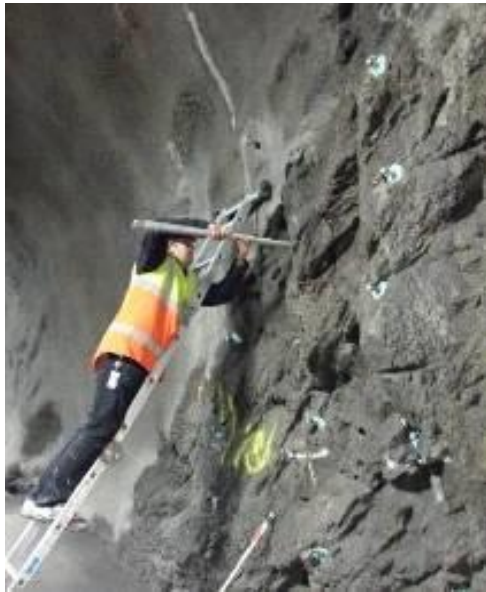
Figur 4. Montering av provkroppar i förborrade hål i Muskötunneln
