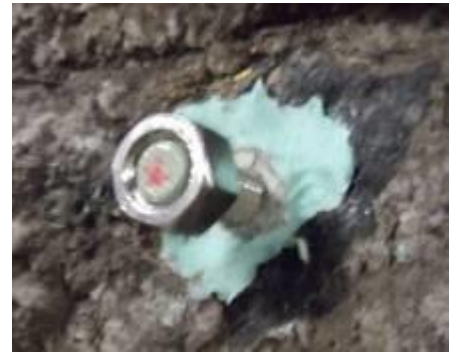
Figur 7. Tätning av spalt mellan cementcylinder och berg
